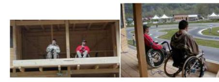
Già il primo palco piloti in tubolari, prevedeva una rampa di accesso che portava la persona in carrozzina ad oltre 2 metri di altezza. Ma con l'attuale palco abbiamo fatto un passo in più: grazie ad una prolunga l'invalido riesce ad uscire di una trentina di cm. in avanti e questo gli permette di avere una visuale molto più ampia senza coperture di sorta. La parte per gli invalidi prevede uno spazio fino a 4 o 5 carrozzine contemporaneamente.
